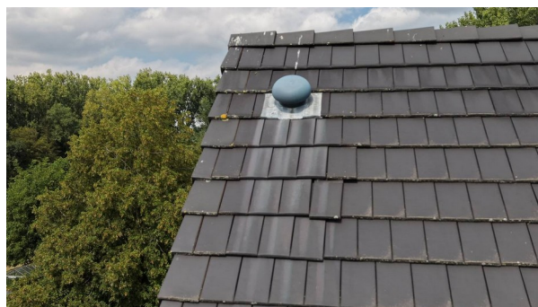
Verschoven pan uit lijn
