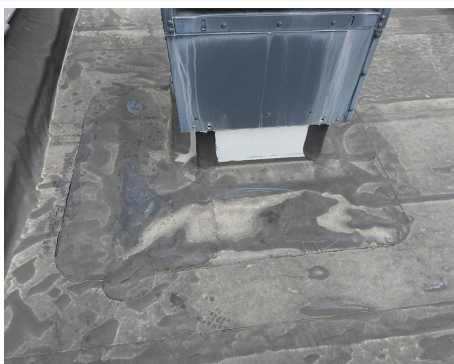
Ingedrukte zone EPDM bij schouwvoet
