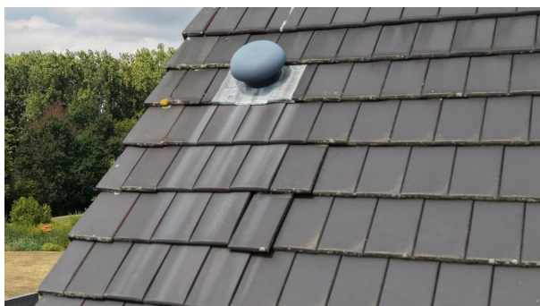
Correcte pannen naast dakdoorvoer
