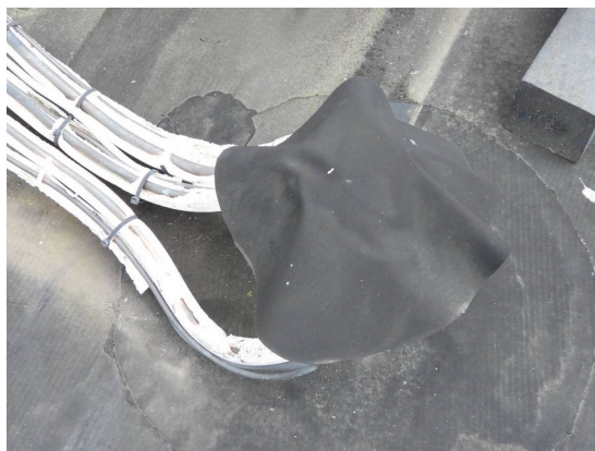
Opgelijmde lap EPDM over de doorvoer
