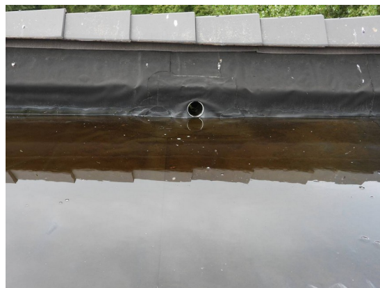
Afvoer boven waterniveau
