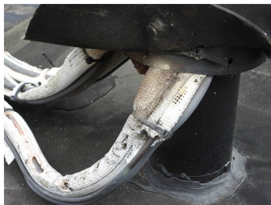
Doorvoer leidingen door verluchtingskap
