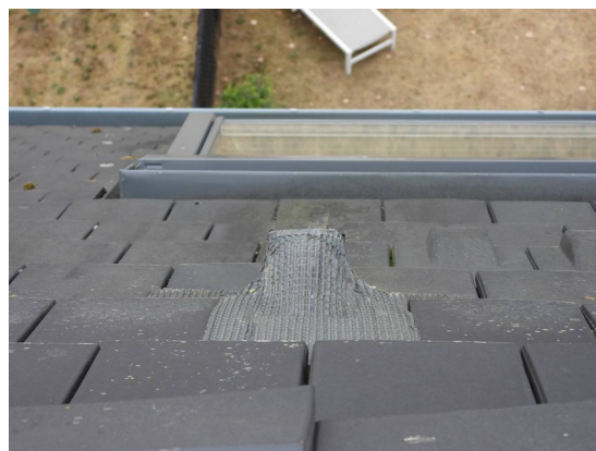
Afvoerpijp boven dakraam
