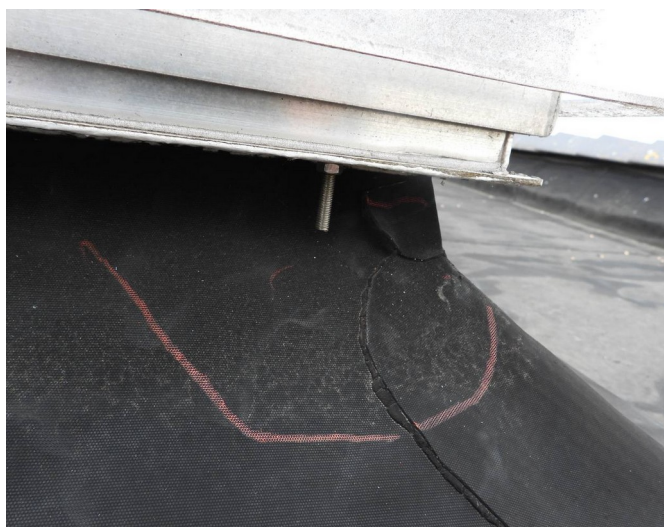
Lage opstand bij dakkoepel
